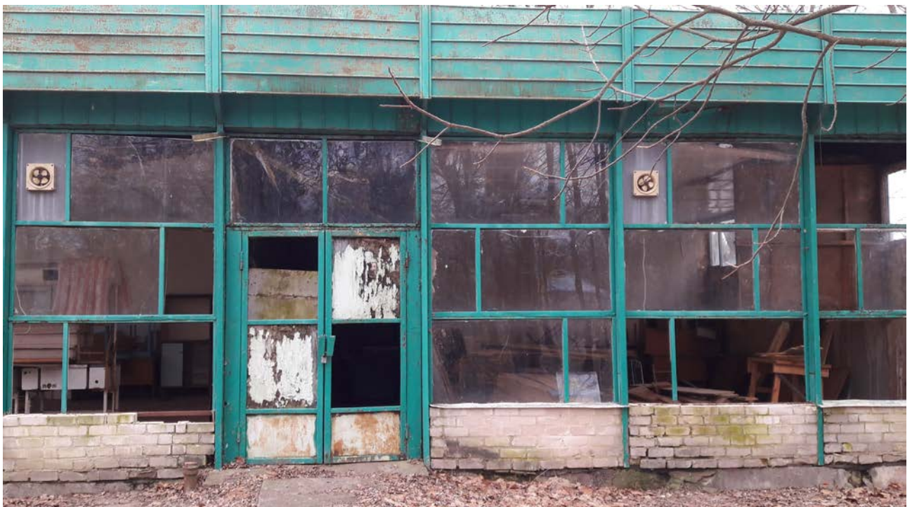
Будівля їдальні бази відпочинку "Рось"
